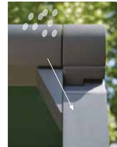
Waterafvoer via de paal
