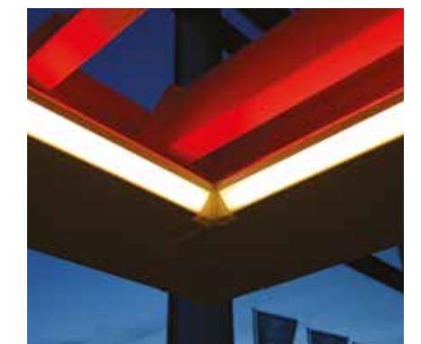
Die Regenrinne kann auch mit einer direkten und/oder indirekten LED-Beleuchtung erweitert werden
